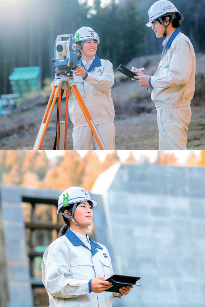
土木現場では写真整理や出来形管理、安全管理などの業務を中心に実施している。小笠原が担当する大和川宅地整備工事では、約40人の作業員を指示し、施工管理を行っている。工事の基本となる測量、写真撮影、作業工程の作成、作業準備などが主な仕事。作業員との信頼関係を築くためには、経験と知識が必要だ。また、初めて経験する工事に直面することも多く、事前準備も重要となる。
