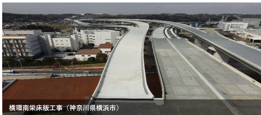
土木事業の特徴と施工実績
